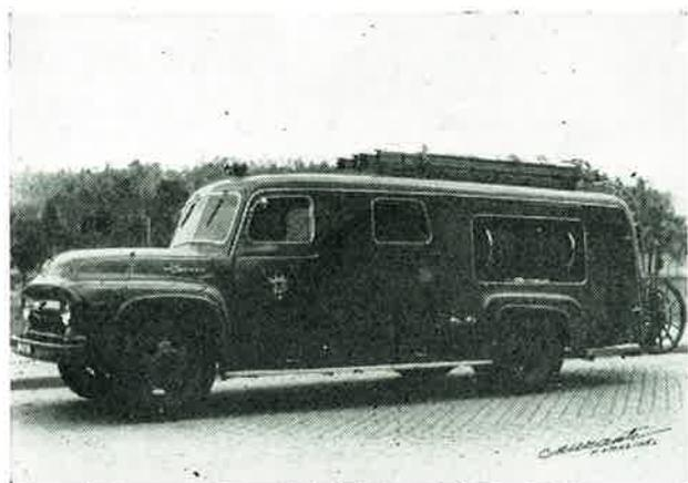
Bomba-tanque para doce bomberos. Lleva 1.700 litros de agua, una bomba acoplada en la parte trasera para baja y alta presión, una bomba portátil inglesa y ochenta metros de manguera rígida a cada lado y con las correspondientes lanzas para poder lanzar agua pulverizada a presión
